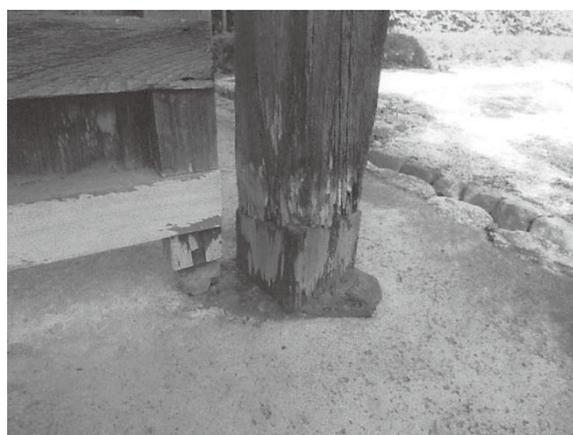
図2 控柱 い-4（修復工事前）
