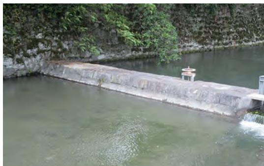
図3. ②水落の堰（落差 1.0m）
