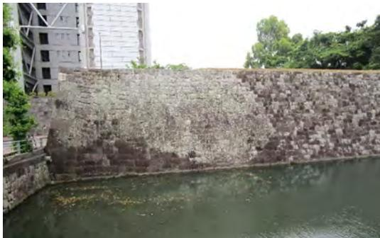
図 11. ⑩外堀県庁前の石垣崩落箇所（幅約 33m）
