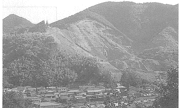
図2. 国道1号線から見た中日本総合開発KKの採石場(露頭の中央部に、左上から右下に斜めに黒く見えるのが断層である)(H15.9.24.長島撮影)。
