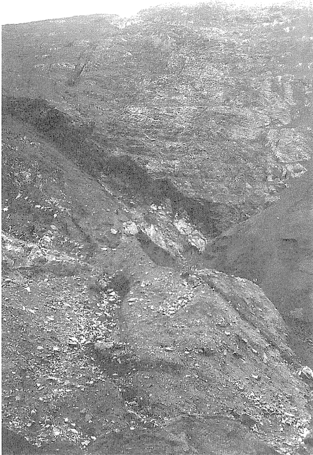
図3. 赤目ヶ谷の断層（走向N10° E, 傾斜40・50° W） （断層の右側は瀬戸川層群の頁岩層, 左側は竜爪層群の粗面岩である）（H14.10.8.長島撮影）。
