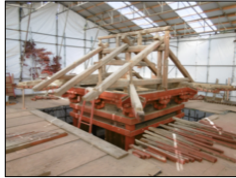
図10 瑞雲院鐘楼堂（修復工事中）
