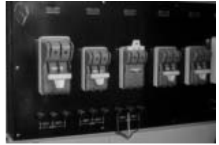
図10 ナイフスイッチ型分電盤
