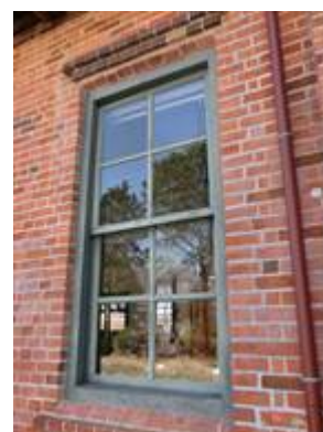
図 2 旧王子製紙製品倉庫 上げ下げ窓
