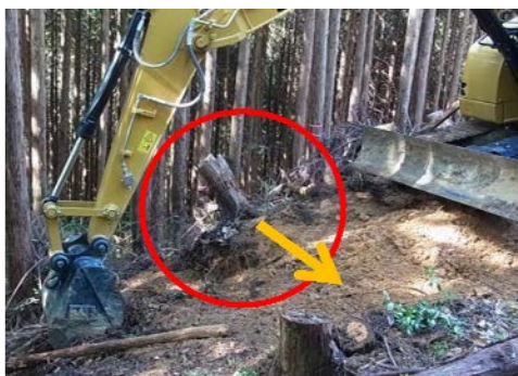
根株移設後 根の伸長方向が通行帯方向へ
