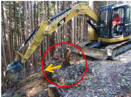
根株（切り株）移設前 根の伸長方向は作業道外方向へ
