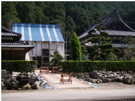
図1 静居寺開山堂保存修理工事現場
