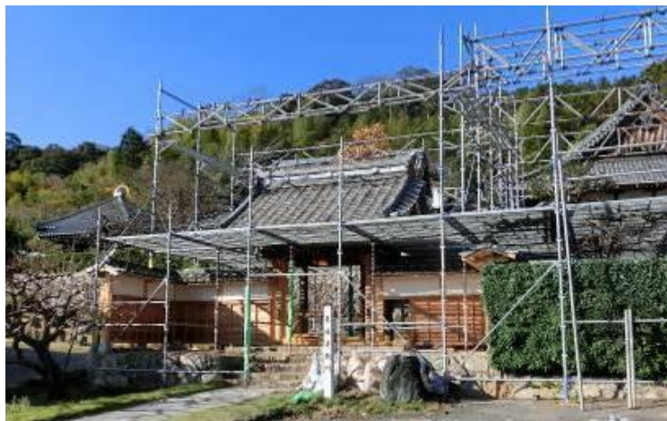
図 1 瑞光山東林寺修復工事中の山門
