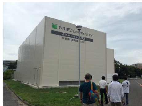
図4. ガスコージェネレーション設備 (2000 kW)
