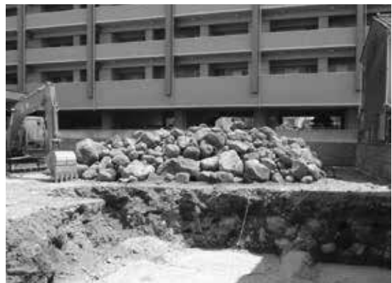
図3. 地点A（三嶋大社付近）の御殿場泥流層
