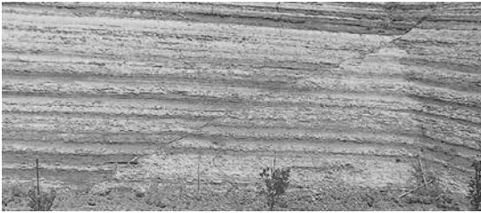
図 11. 断層 II. 上盤が 30 cm すべって下側に移動している正断層である. スケールは 1 m.
