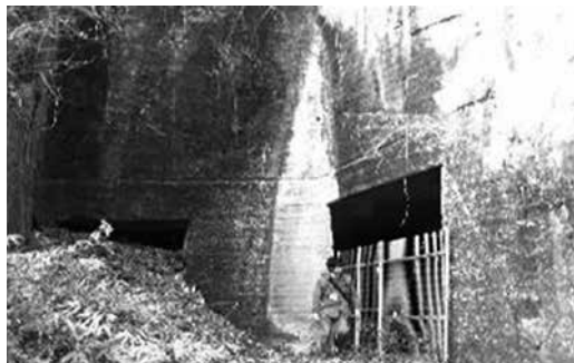
図5. 多比のトンネル状石切場跡.
