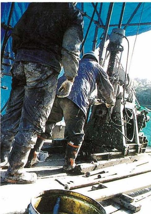
写真5. ボーリング作業中に噴出するメタンガスを処理する。ガスはメタンを主成分で、エタン、プロパン、ブタン、イソブタンなどの炭化水素が含まれている。
