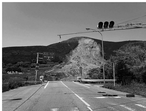
写真4 行方不明者が生じたと推定される阿蘇大橋付近の斜面崩壊(図3のb地点)
