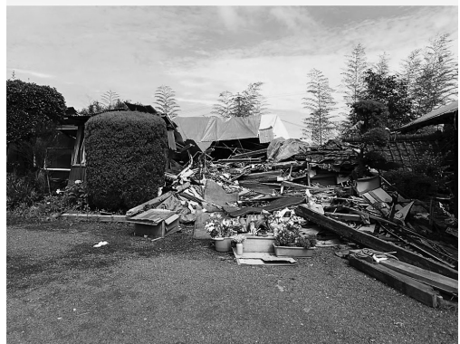
写真9 1階建て建物で犠牲者が発生したと推定される場所（上：西原村鳥子，下：益城町平田）
