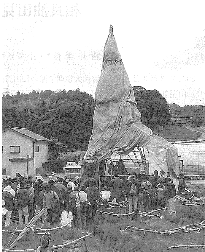
写真2. 菅ヶ谷新田のボーリング作業現場。
