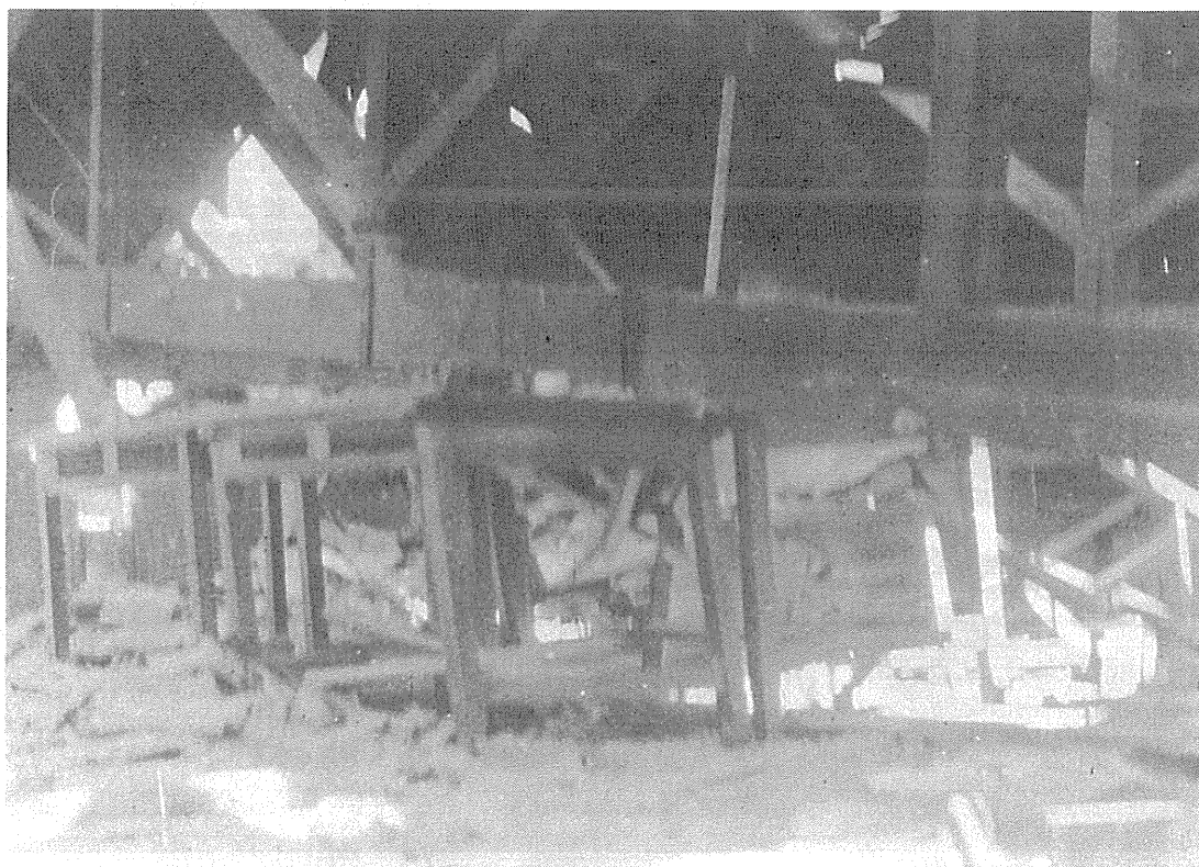
写真3. 遠州機械株式会社工場本部 梁が落ちて、机が壊れている。
