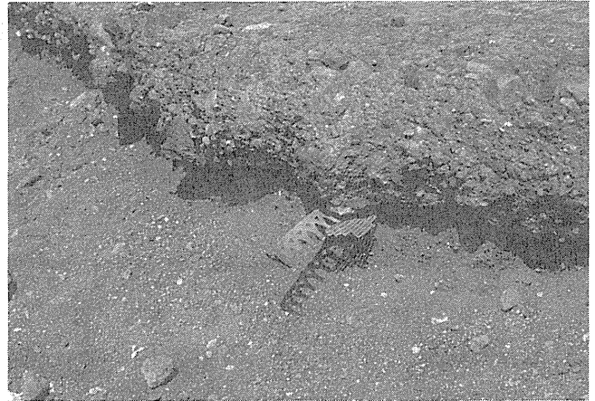
写真4 田子の浦砂丘昭和第一放水路開口部の北付近の投棄土層IIの露頭(写真4の西方約20m、下面に産業廃棄物挟在)
