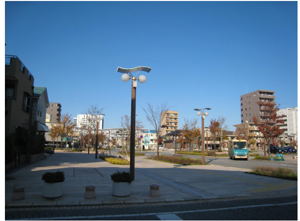
写真4 東第二事業地区の学園通り (幅員 40m, 2008年11月撮影)
