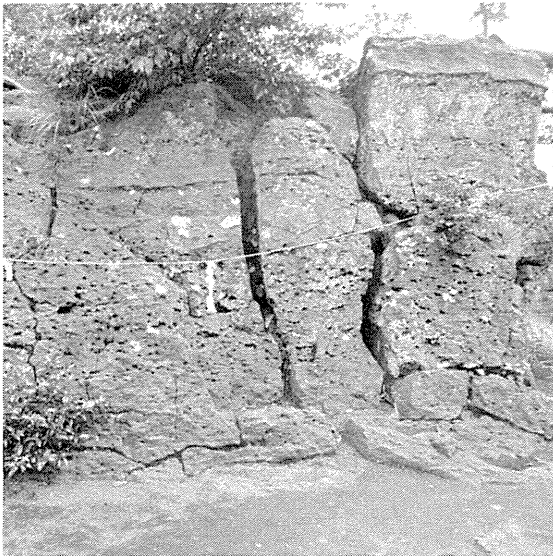
(3) B 丘頂上大裂罅 (壁面に溶岩流を 示す) : 社殿前庭
