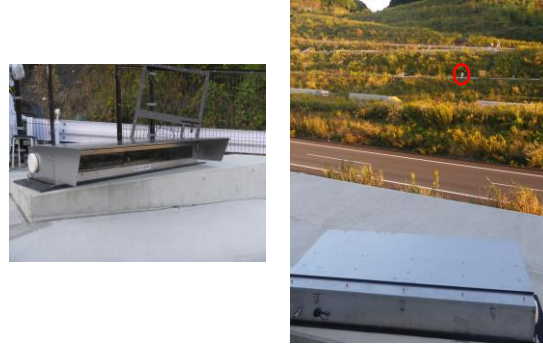
図 5 高速道路の法面の計測の様子
