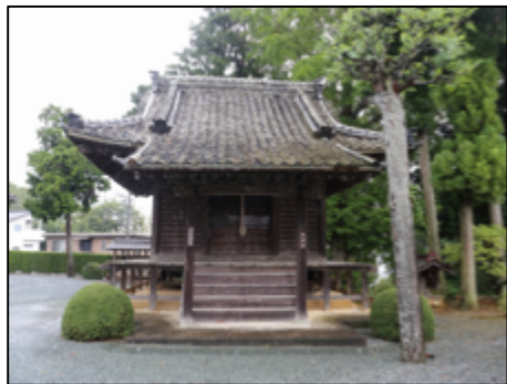
図11 實相寺庚申堂 西面（修復工事前）
