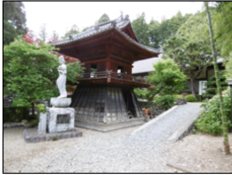
図9 瑞雲院鐘楼堂（修復工事前）
