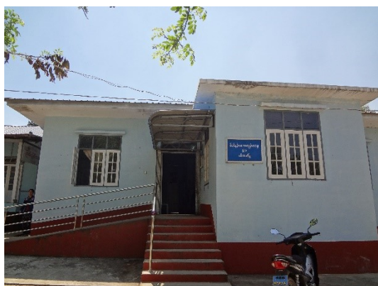
ヘルスセンターの助産部門の建物
