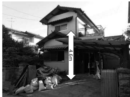
写真-4 倉敷市真備地区で2階まで浸水したとみられる家屋
