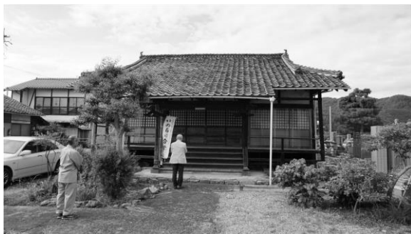
写真 1 建造物の損傷が進む無居住寺院 O 寺
