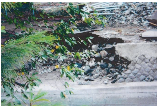
図3. 平成22年 (2010年) 9月の台風9号で決壊した野沢川上の野積みの石垣と打ち上げられた岩石 (保坂, 2011, 2019を転載)。
