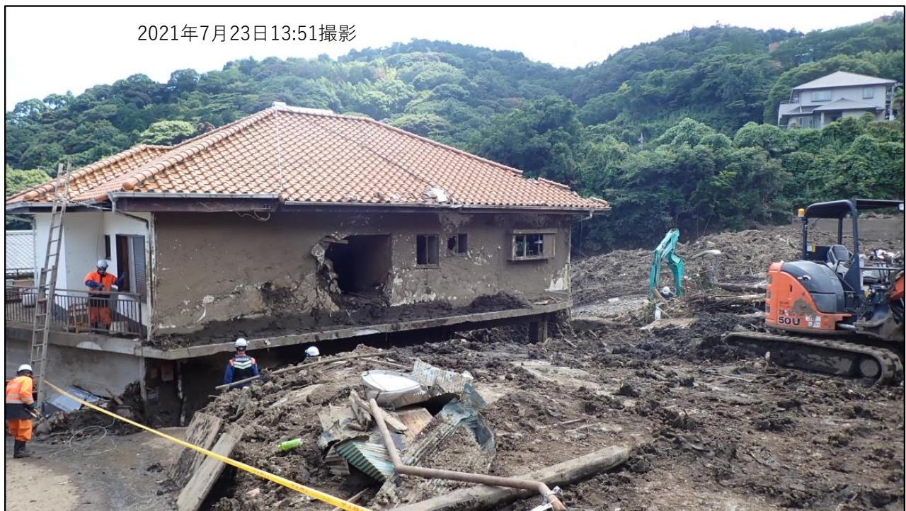
図22 黄褐色瓦屋根の家屋の被災状況。位置は図1に示した。撮影地点の位置は北緯35度6分49.89秒，東経139度4分53.32秒。
