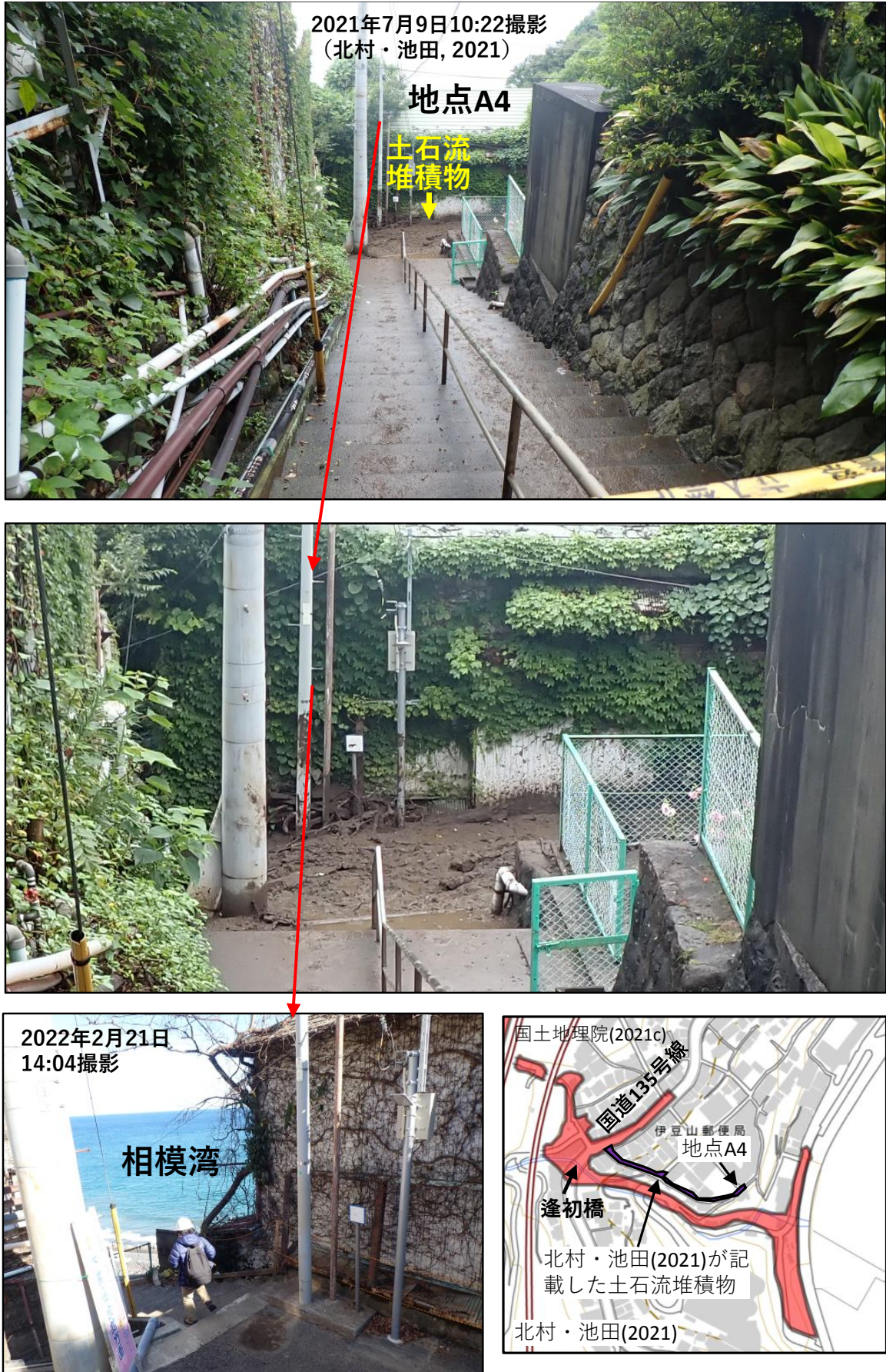
図30 地点A4 (北緯35度6分39.56秒, 東経139度5分9.21秒) の状況。
