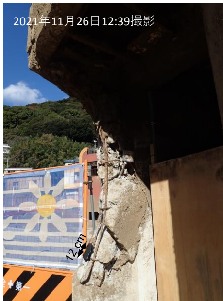
図15 熱海市消防団第四分団（北緯35度6分50.73秒，東経139度4分49.51秒）の建物・車両の破損状況。
