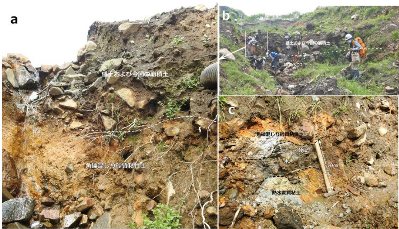
図12 地すべり2の基底部の構造(図6のF地点の窪みの左岸側)。a: 地すべり2とその上に載る盛土および今回の崩積土。盛土の右端の中にコルゲートパイプが見える。地すべり2の下部には角礫が多く、その間の細粒分が流失して隙間になっている。b: F地点の窪みを下流側から見た状況。約3mの深さの窪みになっており、その下部に地すべり2があり、その上に盛土および今回の崩積土となっている。c: 地すべり2とその下の砂礫層、さらにその下の熱水変質粘土。砂礫層は変形しており、また、木片を含んでいる。この木片を 14 C年代測定に供した。
