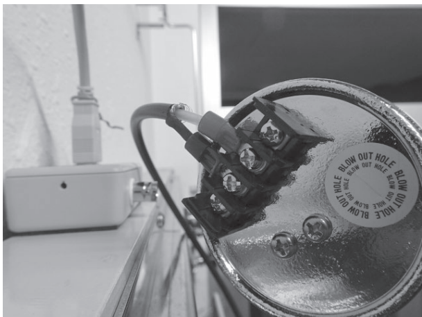
図6 ガスボンベの圧力計と WAN-WAN への接続
