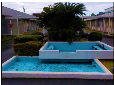
図9 使われなくなった防火水槽
