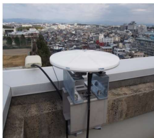
図 23 基準局の設置状況
