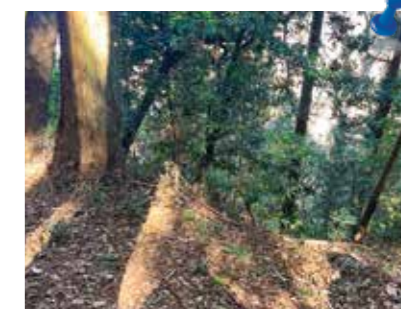
▲相生堂跡地 柵が設置されていない崖
