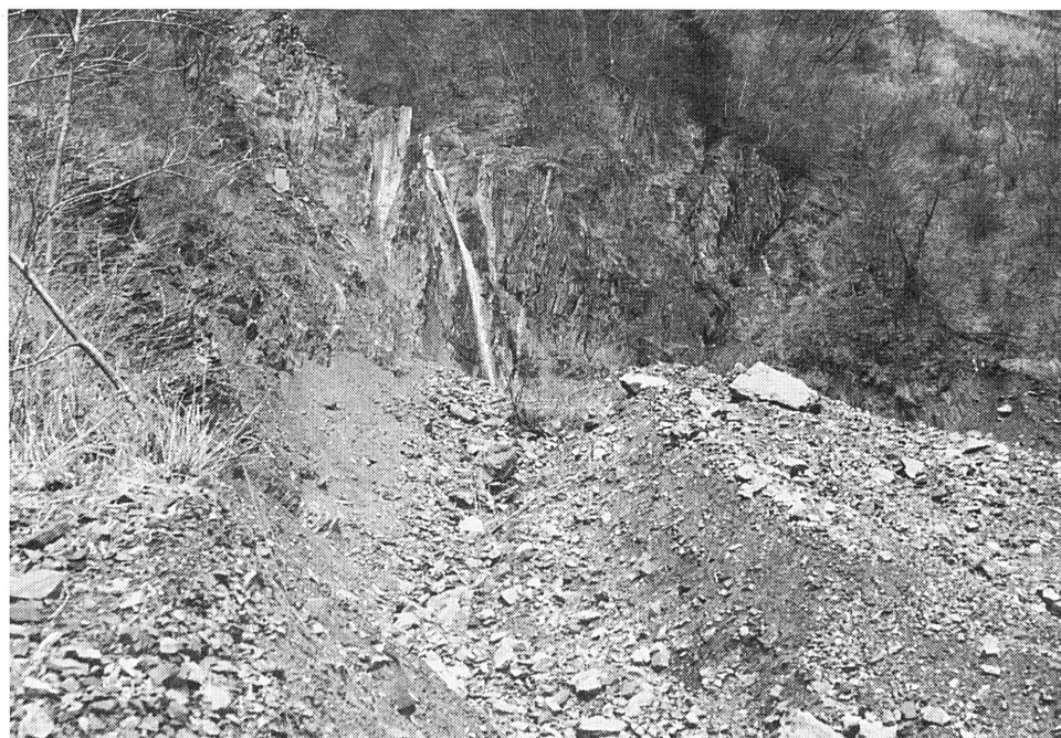
写真一4 大谷大滝右岸の小崩落 (1994 4/16)
