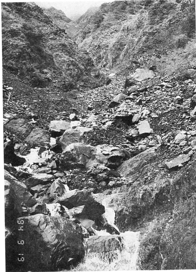
写真一 9 大谷大滝上流の様子 (下流から上流) (1994 9/19)
