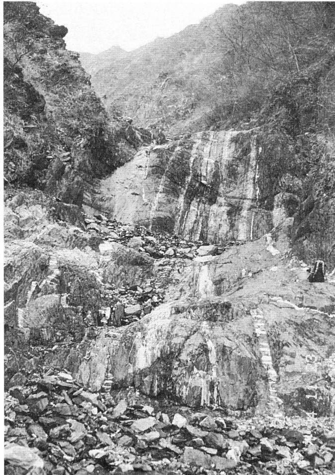
写真一5 大谷大滝上流水圧センサー設置箇所 (1994 11/23)
