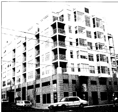
写真4 RC2+木造5階共同住宅(シアトル)
