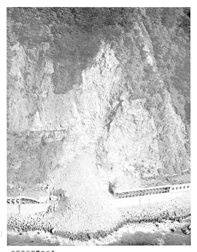
大崩海岸崩壊地全景 崩壊面の標高最高点約99 m、崩壊面の巾約40 m、崩壊土砂量約3,000 m<sup>2</sup> この写真はヘリコプターより撮影したもの。
