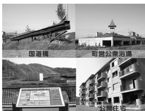
国道橋 町営公衆浴場 公営住宅 図11 金比羅山火口災害遺構公園開設（2004年）
