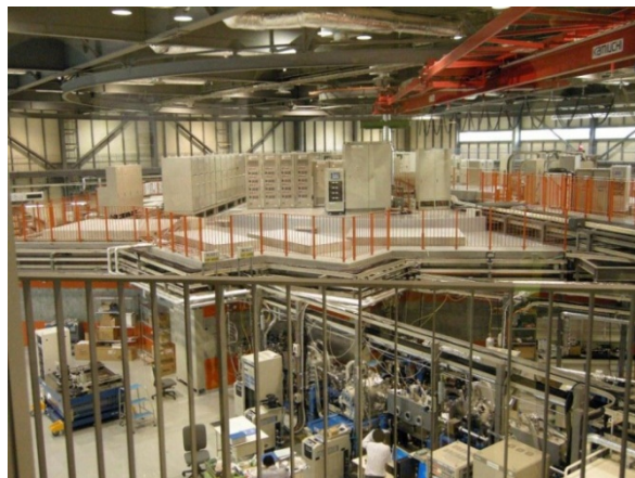
図2 シンクロトロン光発生装置
