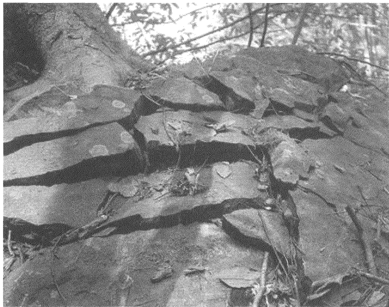
写真7. 川上側（2013年3月）岩に亀甲状の亀裂
