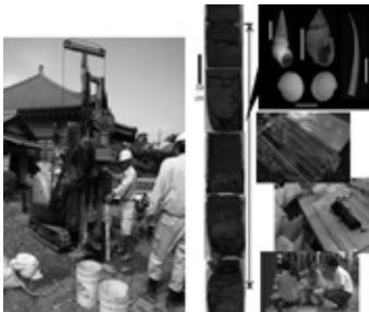
図30 ボーリングコアの掘削
