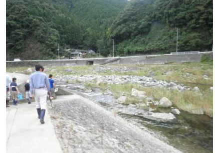
図 6 A6 地点 二川 二川ダムの放水点下流
