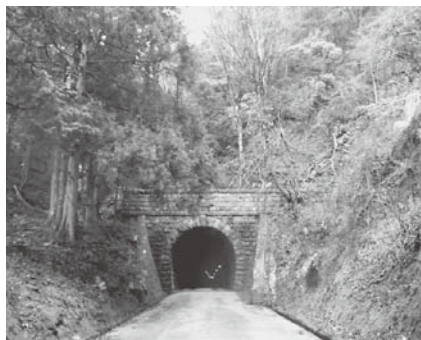
(天城トンネルの下田側)
