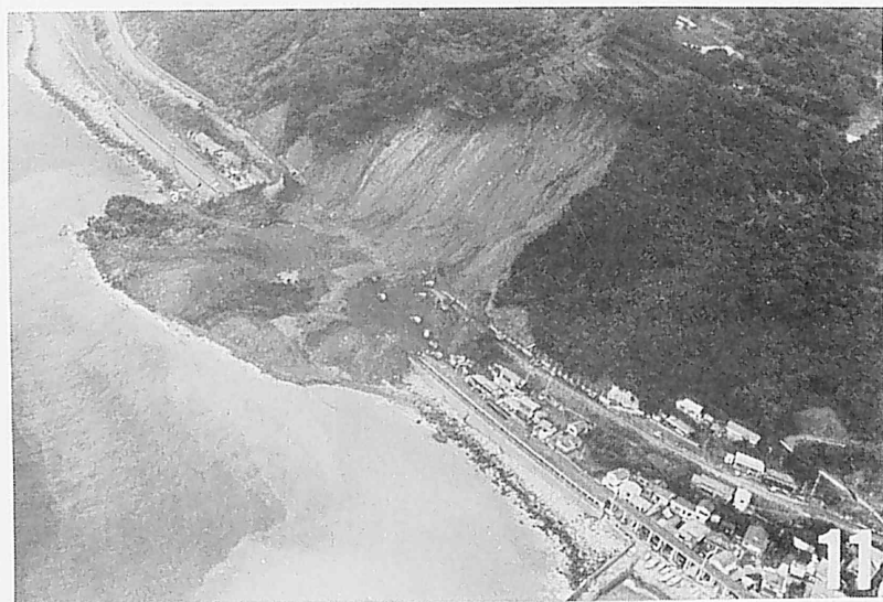
写真11 同地点崩壊直後の状況（昭和51年7月12日、災害対策本部撮影）
