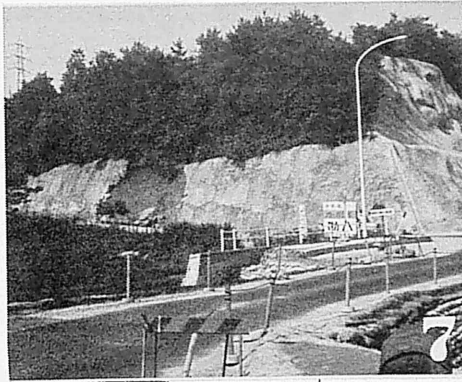
写真7 三河高原勘八峡崩壊地の崩壊直後の状況（昭和47年7月17日撮影）
