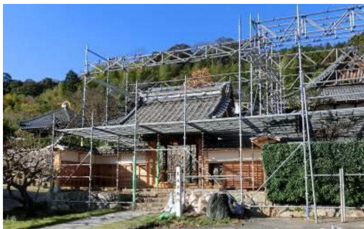
図 1 瑞光山東林寺修復工事中の山門
