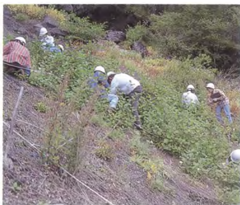
写真5-3 崩壊斜面への木本植物の侵入
