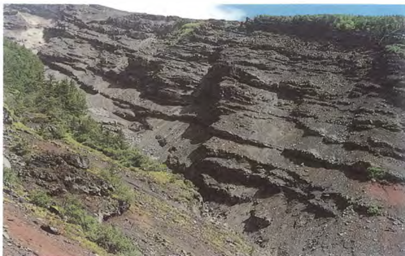
写真5-1 大沢崩れ南斜面（左岸側）
