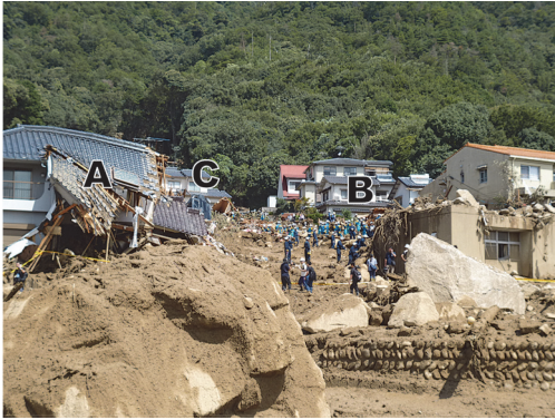
写真2 災害直後の図8付近。2014年8月21日撮影。
