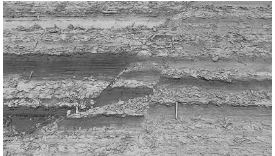
図 12. 断層 III. 東側(図右側)は上盤が 20 cm すべって下側に移動している正断層だが, 西側(図左側)は下盤が 30 cm すべって下側に移動している逆断層である. スケールは 20 cm.
