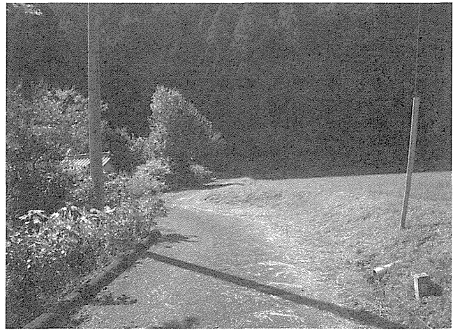
図2. 金原の横ずれ断層 (約8 m左横ずれ)。
