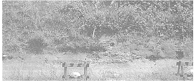
図4. 掛川市小市，東側露頭の北側全景。工事標識の高さは80 cm.
