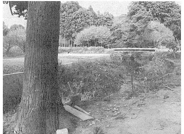
図6. 牛ヶ池通りの新川をまたぐ木橋を西側から見たところ。手前の杉の木と木橋の中間点付近に見られる。
